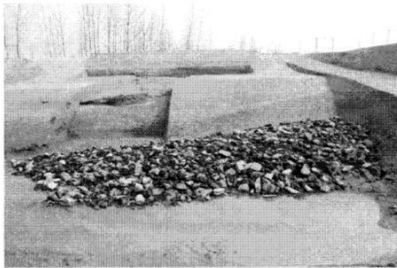
图八// 顺黄坝遗址2012年发掘揭示的碎石坦坡
