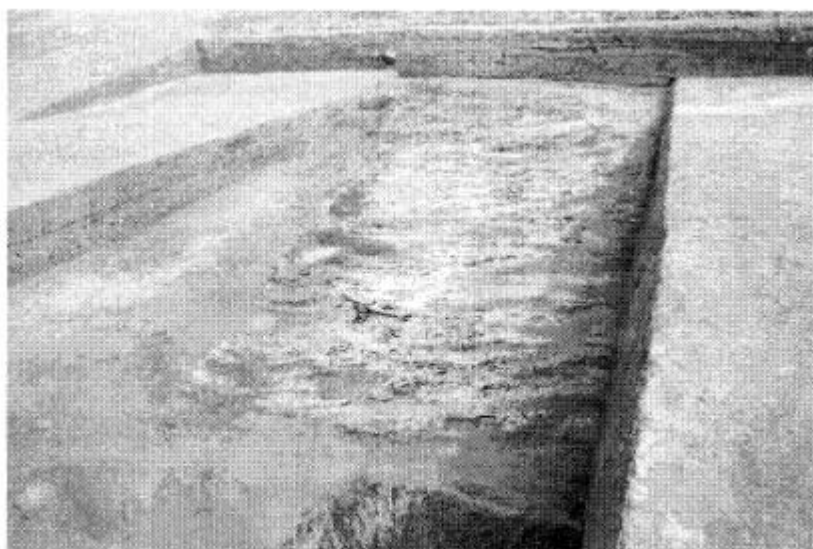
图一〇// 顺黄坝遗址 2012 年 TG1 内的埽工
