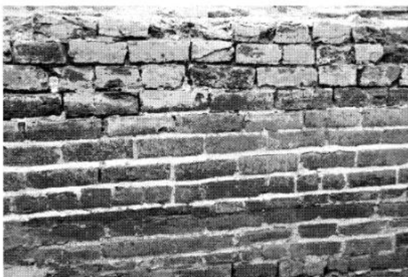
图五// 明代天妃坝砖工之间的白灰层
