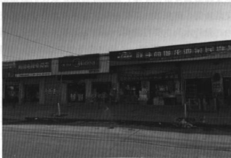
图7 龙池镇建筑现状
