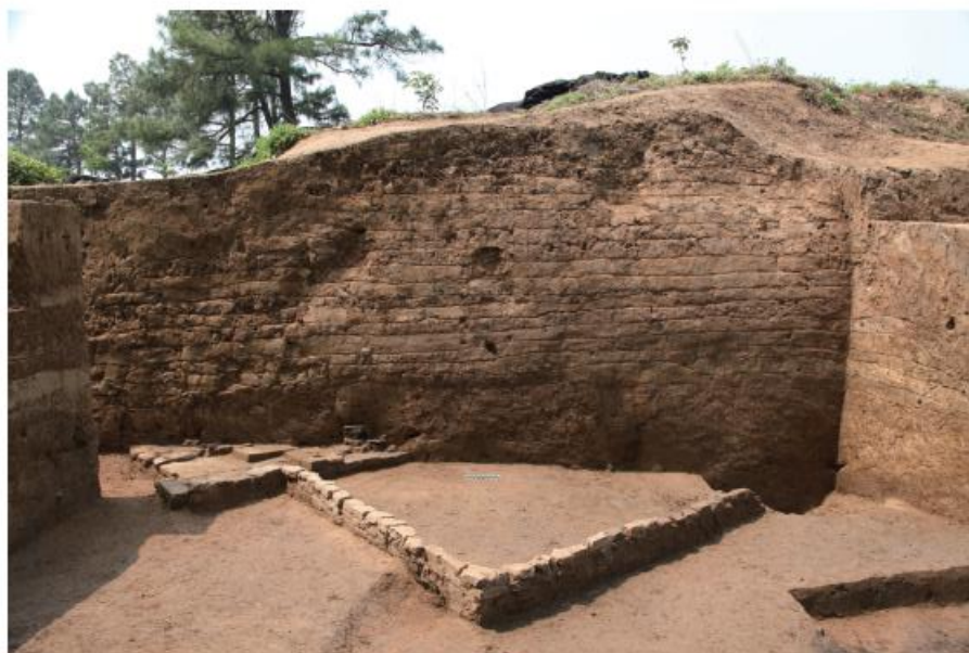
2.YSTG1G南壁瓮城墙夯土墙体(东北—西南)
