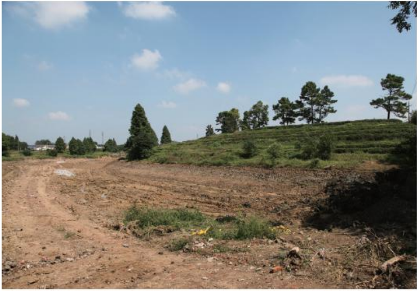
1.瓮城墙及其外(西)侧瓮城壕地貌(东南—西北)
