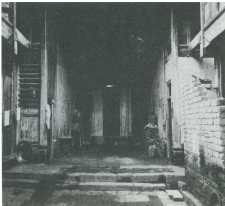
图7 宝石村民居院落的天井
