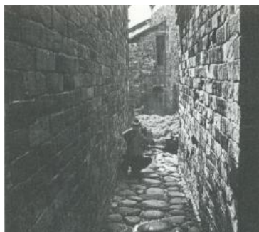
图 14 宝石村传统民居村落的地面铺装图
