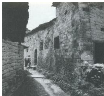
15 宝石村民居巷道入口地面铺装
