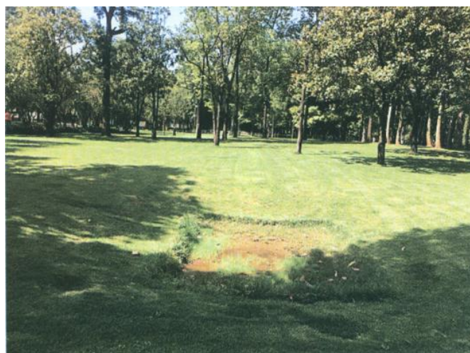
图 4 西华公园下凹式绿地集水示意图
