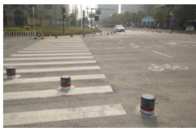
图2 西区交叉口人车分隔线
