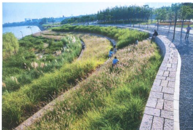
图2 金华燕尾洲公园中的梯田式生态护堤
