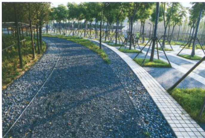
图3 金华燕尾洲公园中的透水铺装
