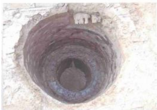
1.唐井整体现状
