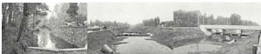
图 6-20 干河村百米石渠现状
