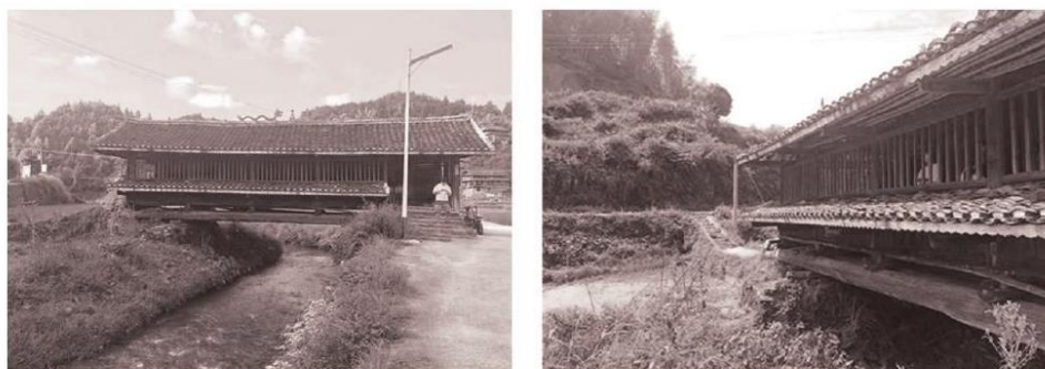
图4、5 金哨风雨桥现状
