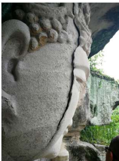
图二//大足石刻石雕像表层岩体风化破坏（1 厘米）
