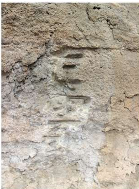
图一//云冈石窟题刻表层岩体片状风化破坏
