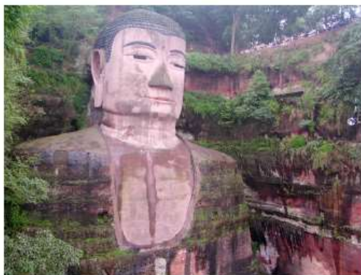
图六//乐山大佛饱受大气降水和地下水的侵蚀破坏
