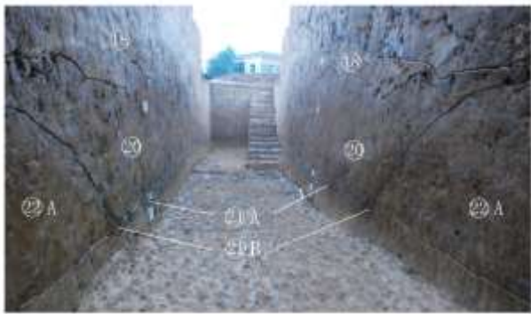
图一八 TG1 东、西两壁墙体基础及主墙体堆筑结构（镜向北）
